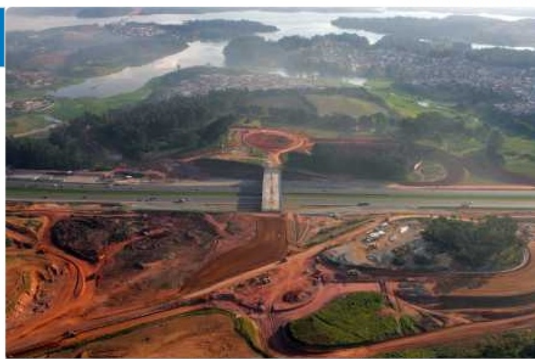
Imagens do Rodoanel em obras
